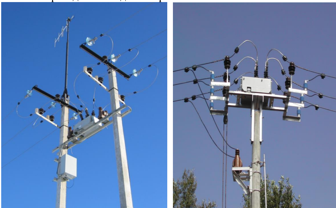
Рисунок 1 – Реклоузер вакуумний типу РВА/TEL-10-12,5/630
