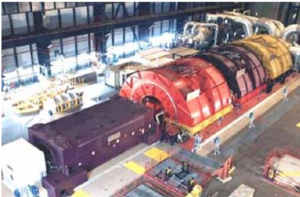
Рисунок 1 – Чотириполосний потужний синхронний генератор потужністю 1710 МВА який працює 1996 року у Франції [2]
