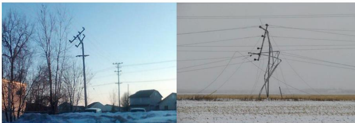
Рисунок 1 – Пошкодження стовпа та вигинання стовпа
