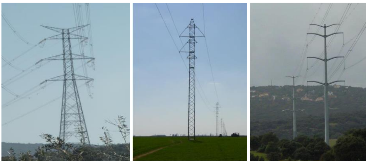
Рисунок 5 – Решітчасті опори з: а) широкою основою та окремими фундаментами, б) компактним фундаментом; в) одиночні опори з компактним фундаментом.
