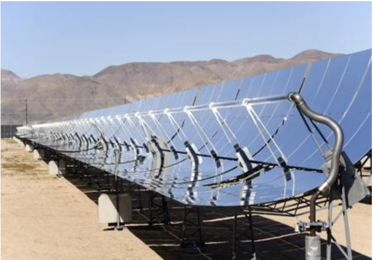
Рисунок 1 – Параболоциліндричний концентратор
