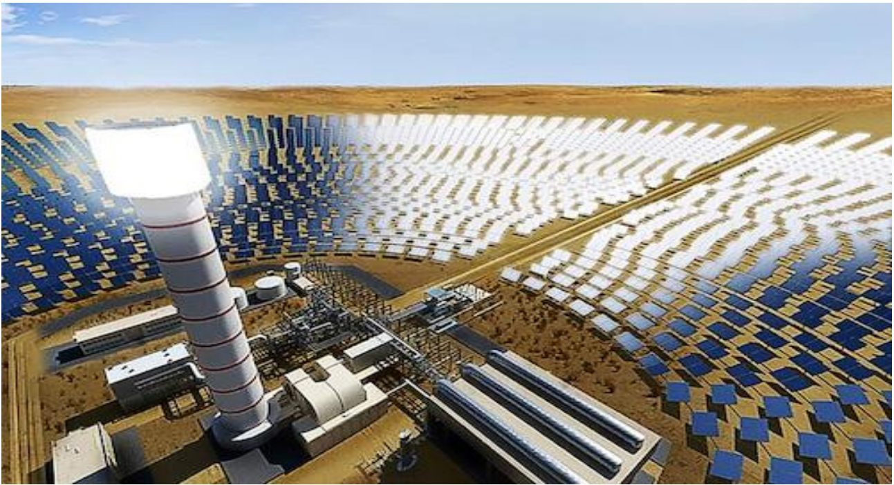
Рисунок 3 – Геліоцентрична установка баштового типу
