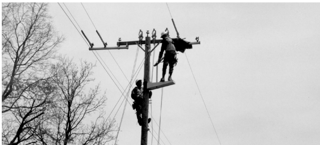
Рисунок 3 – Робота під напругою із застосуванням ізолювальної площадки
