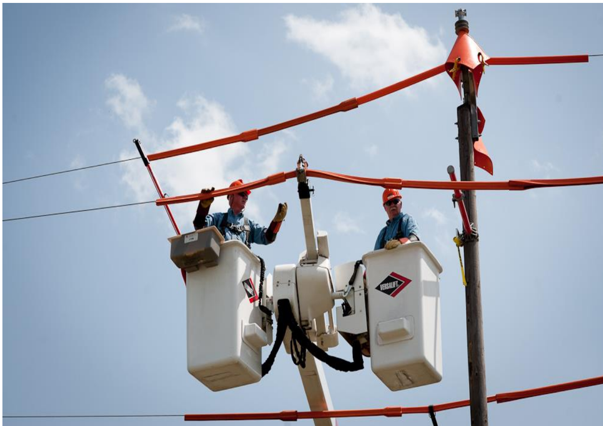
Рисунок 2 – Виконання ремонтних робіт на ПЛ під напругою
