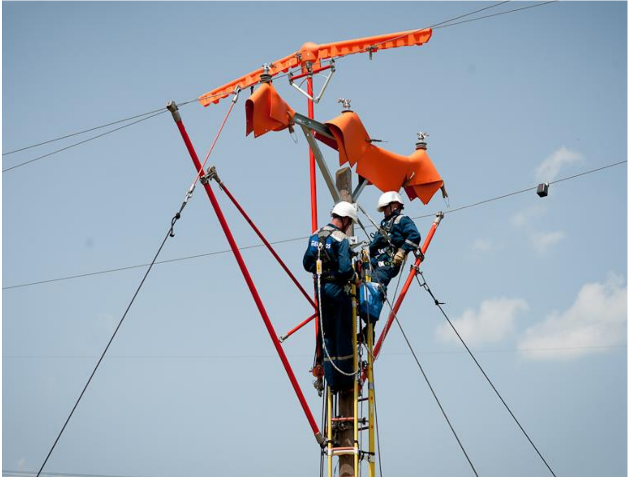
Рисунок 4 – Проведення робіт ПРН з ізолювальної драбини
