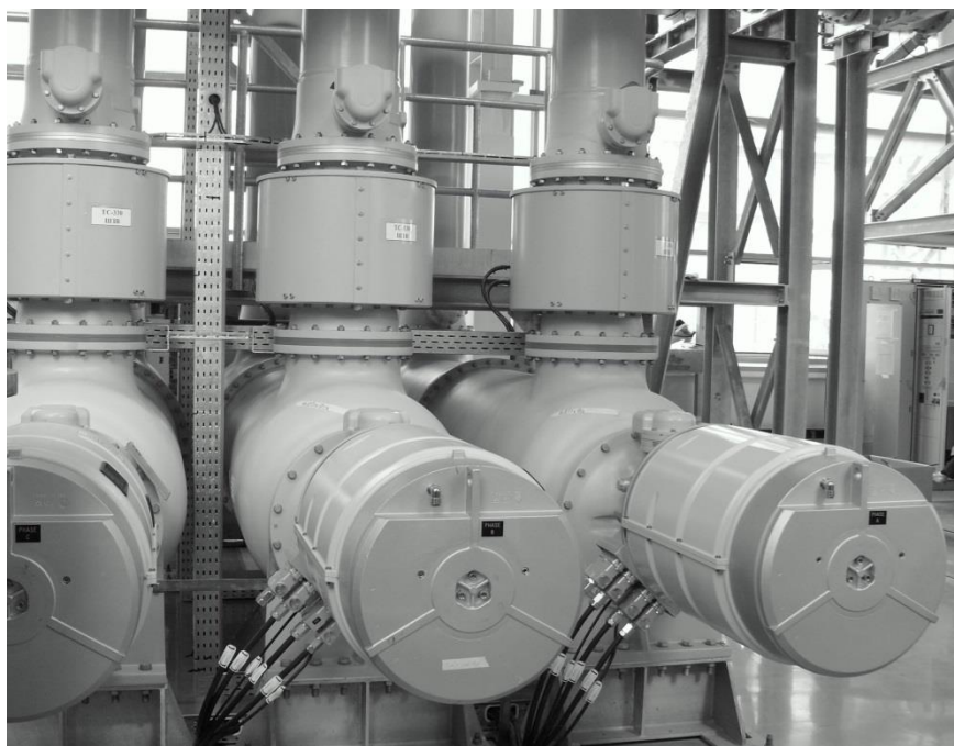
Рисунок 2 – Загальний вигляд елегазових вимикачів КРПЕ 330 кВ
