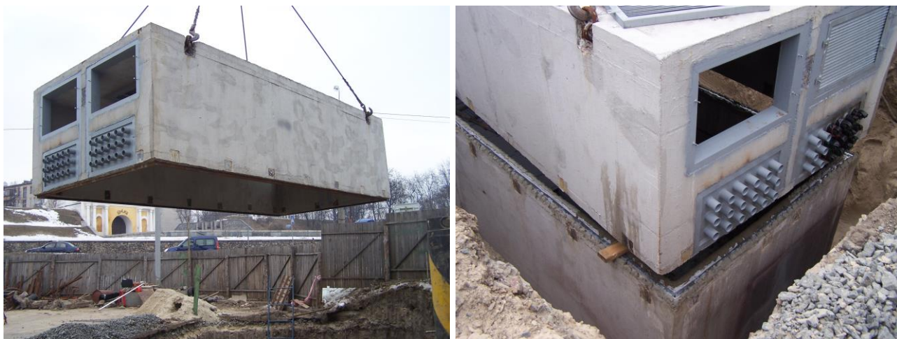
Рисунок 3 – Монтаж верхнього монолітного бетонного блоку
