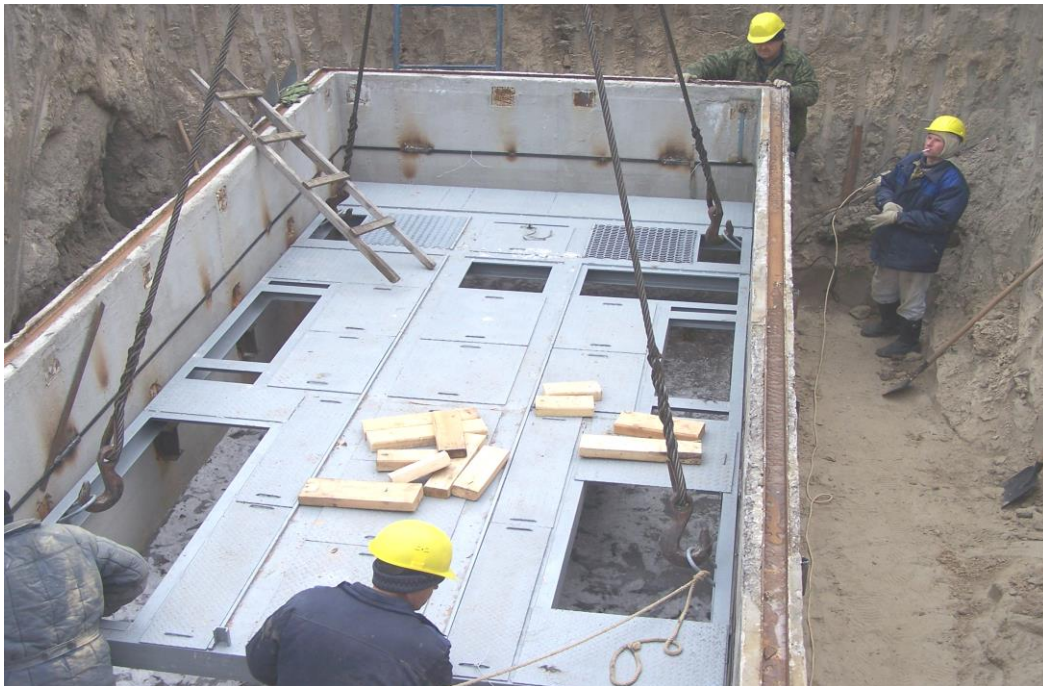
Рисунок 2 – Монтаж нижнього монолітного бетонного блоку
