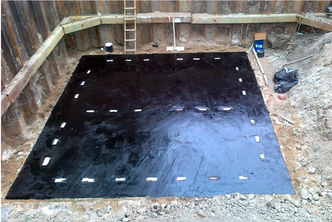
Рисунок 1 – Загальний вигляд підготовленого котловану
