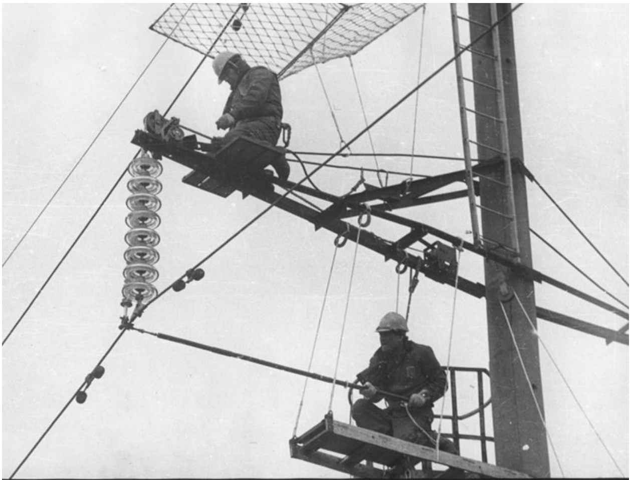
Рисунок 1 – Робота під напругою на проміжних опорах ПЛ 110 кВ
