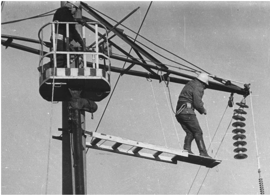
Рисунок 2 – Використання навісного трапу під час ремонту гірлянди ізоляторів на ПЛ 110 кВ
