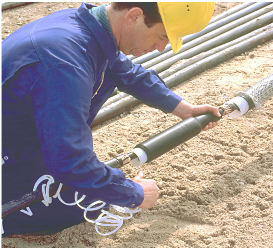
Рисунок 2 – Монтаж кабельної муфти холодної усадки
