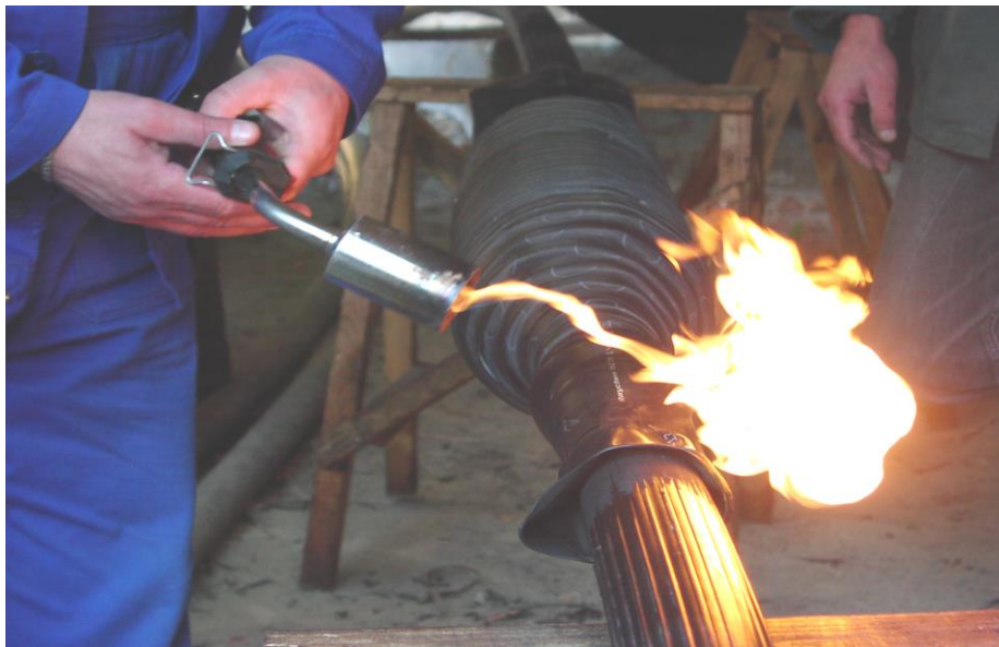
Рисунок 1 – Монтаж термоусаджувальної кабельної муфти
