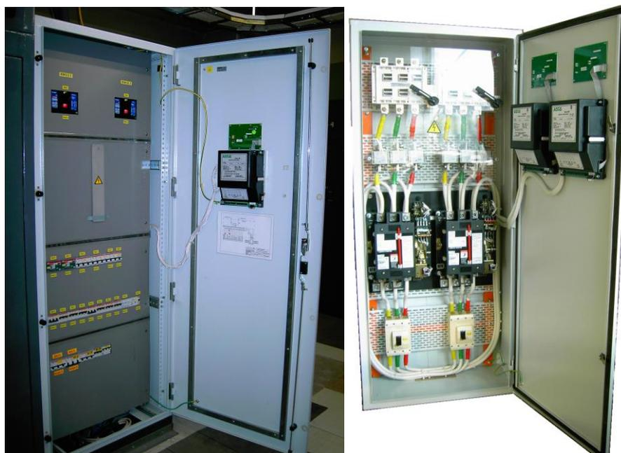
Рисунок 2 – Общий вид шкафов АВР, применяемых в СГЭ
