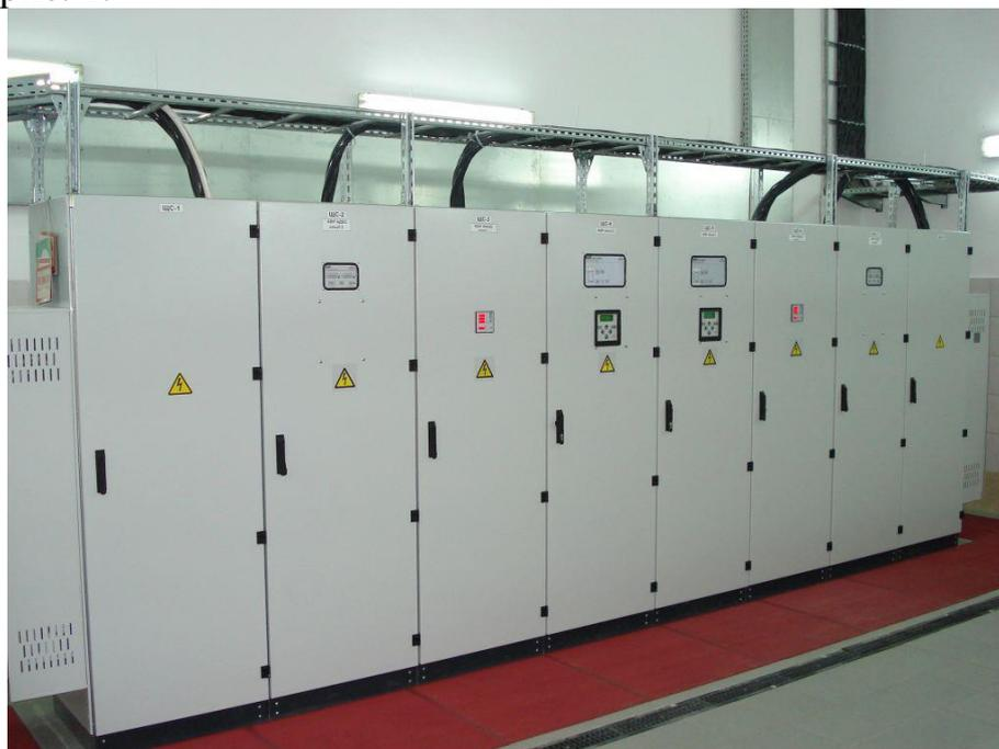
Рисунок 1 – Вариант реализации шкафов системы гарантированного электроснабжения
