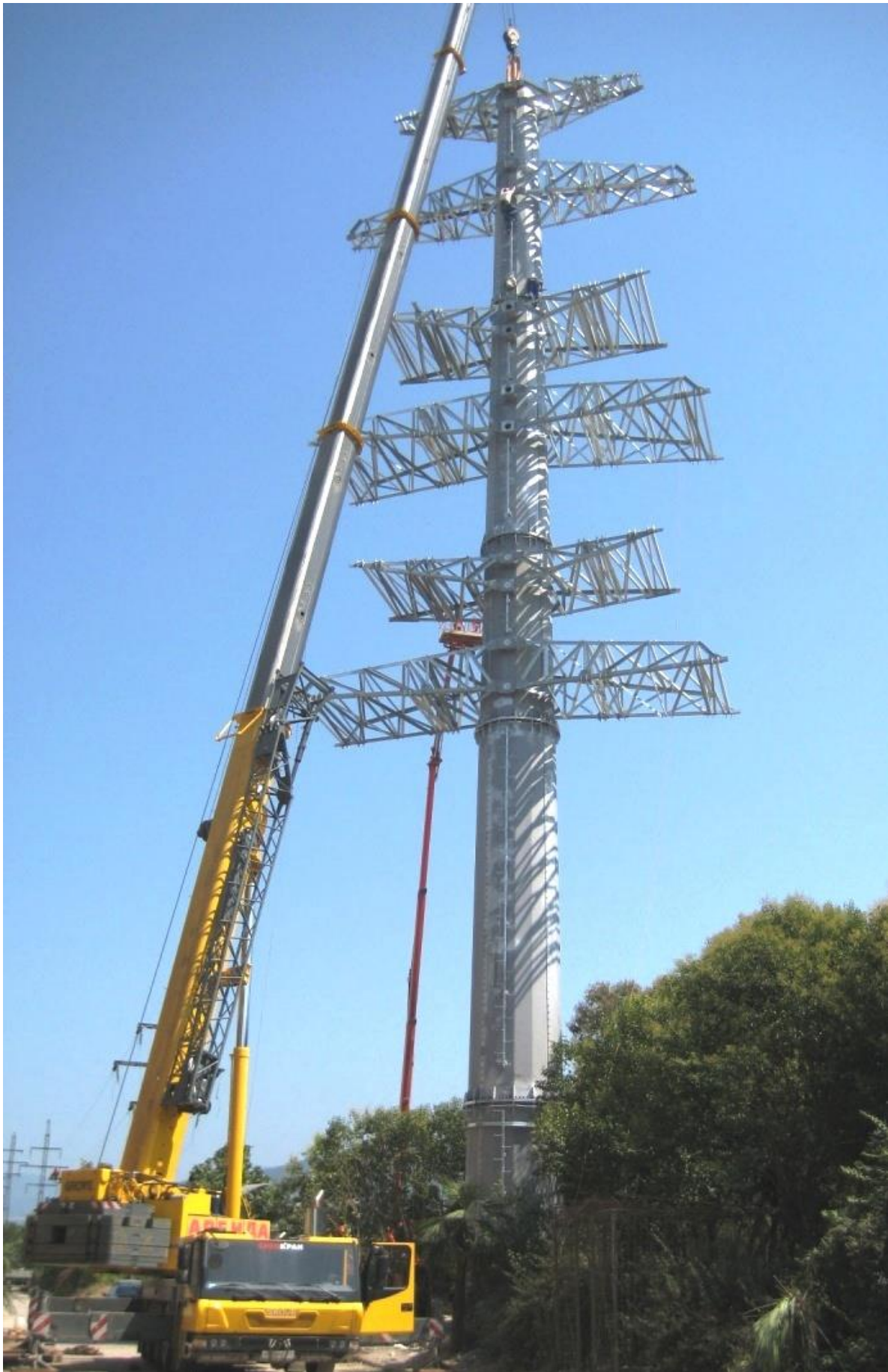
Рисунок 3 – Приклад встановлення багатоголової опори ПЛ
